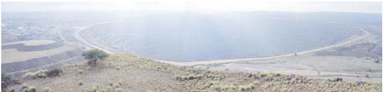
Южная Африка, Палабор – открытое месторождение меди. Плавный пуск для конвейеров, дробилок и мельниц.
