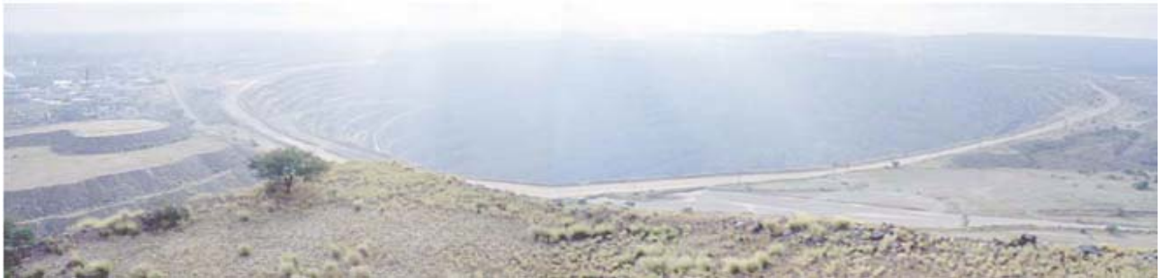
Южная Африка, Палабор – открытое месторождение меди. Плавный пуск для конвейеров, дробилок и мельниц.
